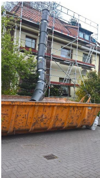
Putkea pitkin vanhat tiilet alas ja nostolaitteella uudet tiilet ylös
